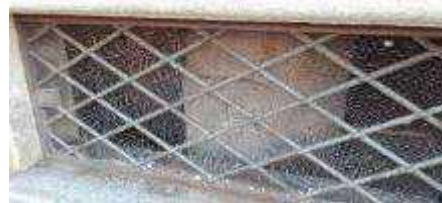
Accesso dal lucernaio situato sul marciapiede di Piazza Navona a destra della Chiesa.
